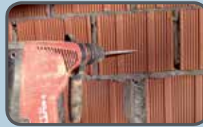
Verifica delle caratteristiche della parete
