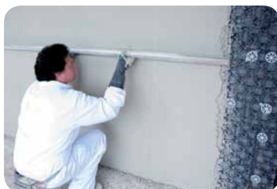
Staggiatura e calibratura dell'intonaco
