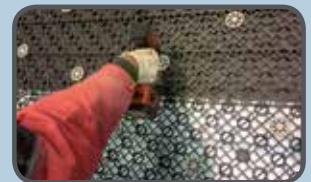
Posizionamento, foratura e fissaggio delle lastre RXL
