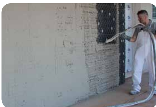
Applicazione dello strato di intonaco
