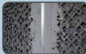
Posizionamento delle guide per determinare lo spessore dell'intonaco RXM
