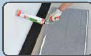
Applicazione della schiuma poliuretanic sulle lastre RXL
