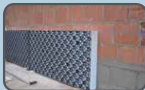
Posizionamento, foratura e fissaggio delle successive lastre RXZ
