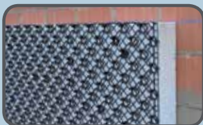
Posizionamento della prima lastra RXZ
