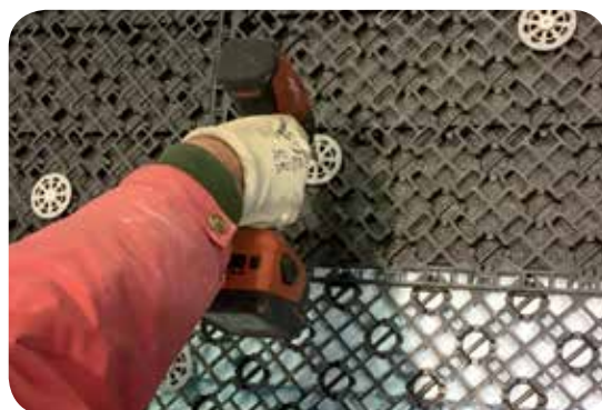
Fissaggio meccanico delle lastre con tasselli
