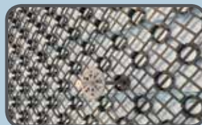
Fissaggio meccanico della prima lastra RXZ
