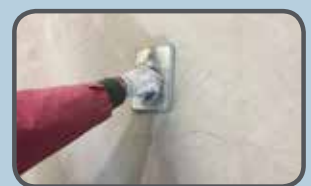
Perfezionamento della parete
