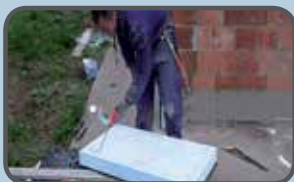
Applicazione della schiuma poliuretanica sulle lastre RXZ
