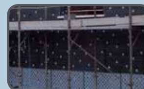
Come deve presentarsi la parete prima dell'applicazione dell'intonaco di fondo RXM
