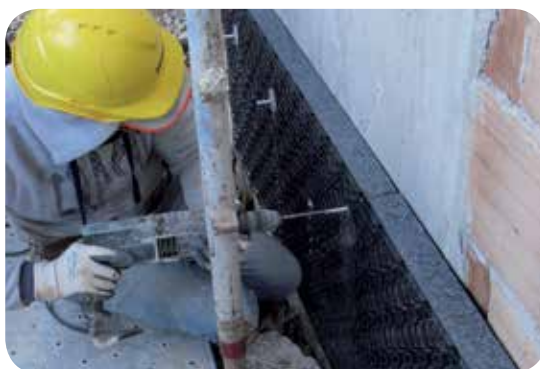
Foratura delle lastre
