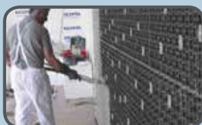
Applicazione meccanizzata dell'intonaco di fondo RXM
