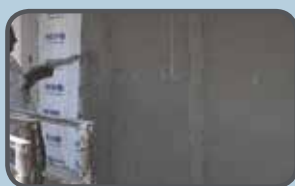
Applicazione meccanizzata dell'intonaco di fondo RXM
