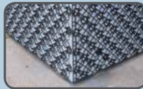
Posizionamento, foratura e fissaggio della lastra d'angolo RXZ
